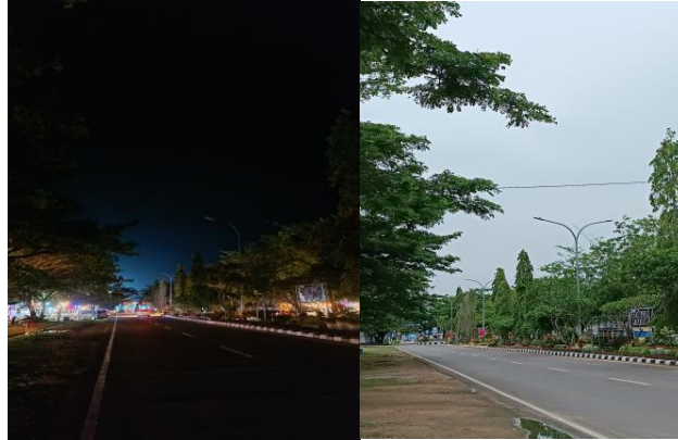
Gambar 2. Kondisi Penerangan Jalan Area Menuju Pelabuhan Raha
