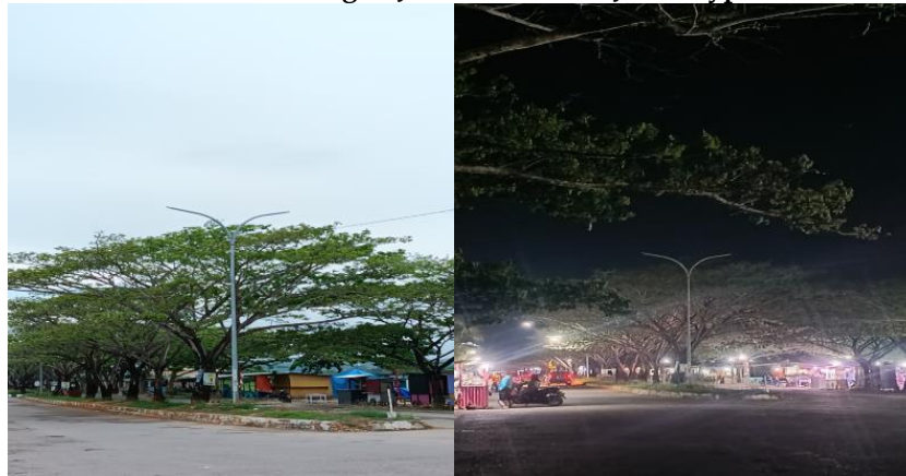
Gambar 1. Penerangan Jalan Umum Di Jalan Bypass Raha
